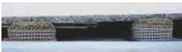
Spezielle Höhenausgleichsringe dienen als Schalung für den Mörtel. Die 27 oder 50 mm hohen Ausgleichsringe können problemlos mehrfach übereinander gesetzt werden. Damit ist der Höhenausgleich von bis zu 150 mm möglich. So lässt sich das Belagsgefälle einfach einstellen
