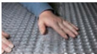
Verlegung der DURABASE DD 80++ Doppel-Drainagematte mit Überlappung
